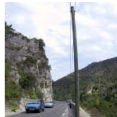
Enfouissement des réseaux - VALORISER
